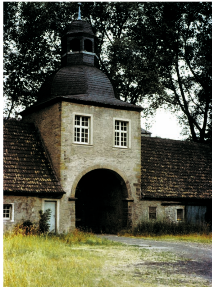
Torhaus des ehemaligen Ritterguts Haus Niederhofen, um 1975
