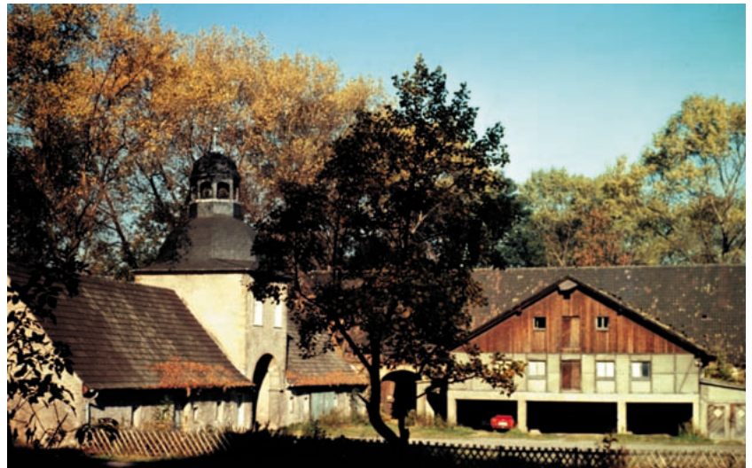
Gut Niederhofen vor dem Umbau zum Kinderheim, um 1975
